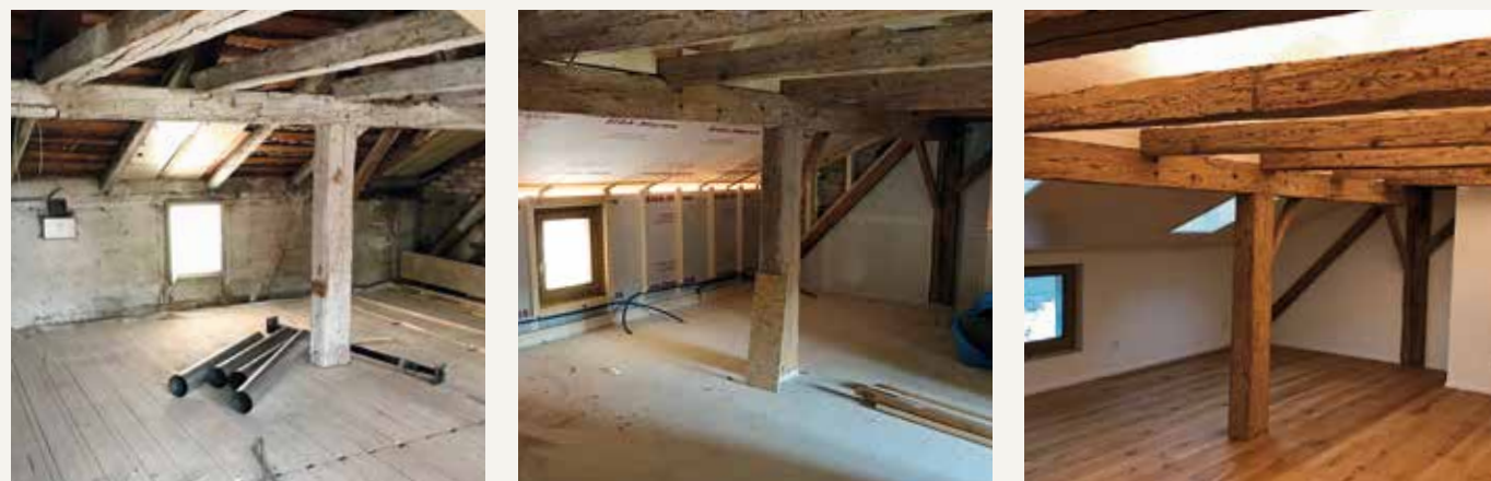
Sorgfältig umgesetzt: Der Umbau des Dachbodens im denkmalgeschützten Gebäude verlief reibungslos.
