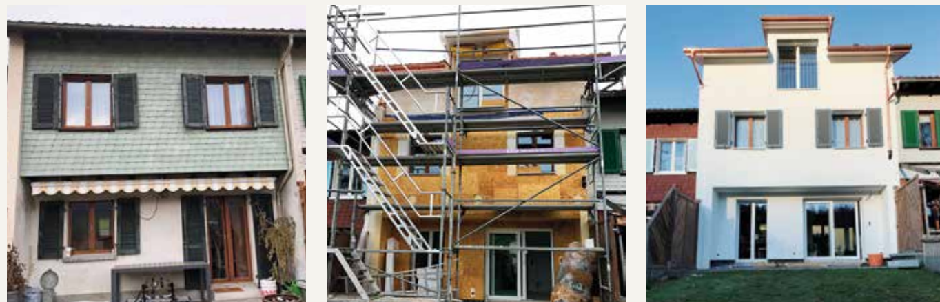
Hoch hinaus: Die Aufstockung schafft Platz.
