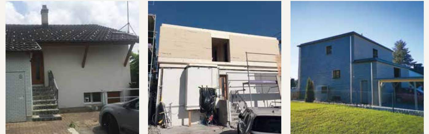
Umgestaltet: Aus dem Giebel wird ein Flachdach.
