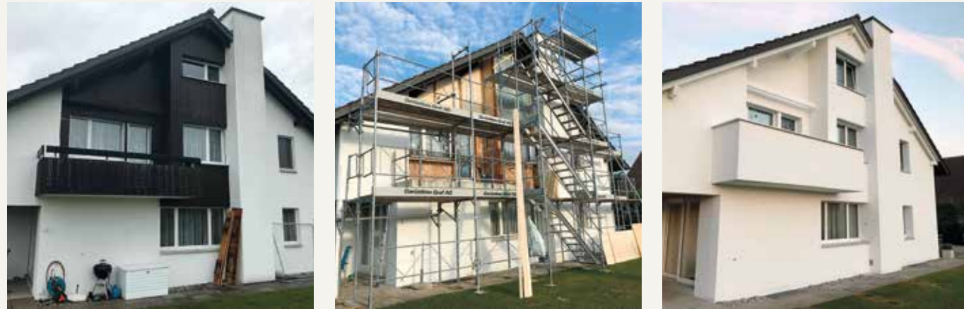
Wertsteigernd: Die Sanierung der Fassade schafft Mehrwert – auch in Sachen Energieeffizienz.
