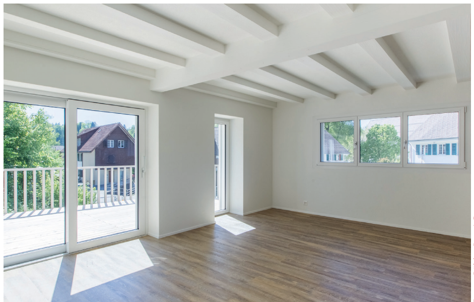
Eine Hebeschiebetüre ersetzte ein normales Fenster und erhöhte den Tageslichteintrag merklich.
