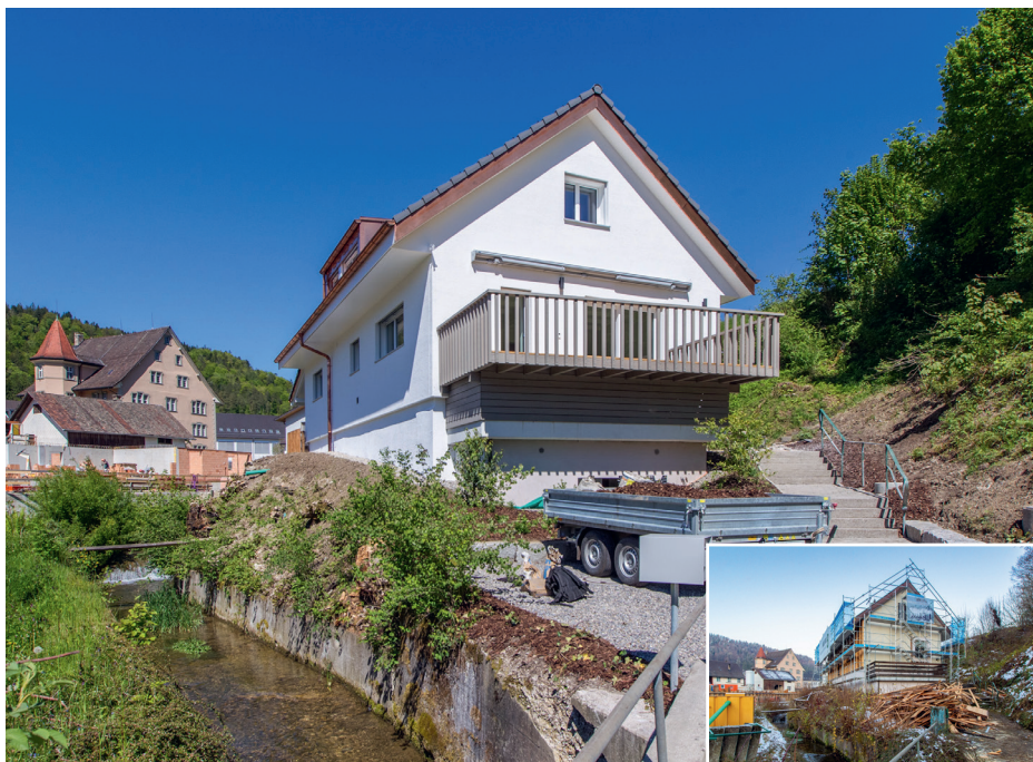
Die Bähler Bau AG hat das unscheinbare Einfamilienhaus im Turbenthal gesamtsaniert und zu einem schmucken Haus umgebaut.
